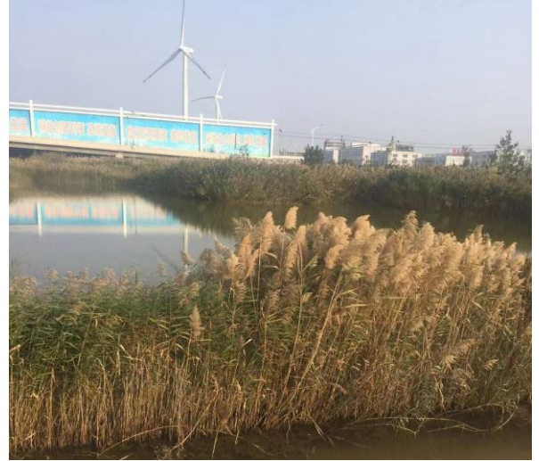
运盐河船闸施工期拌合站现状
