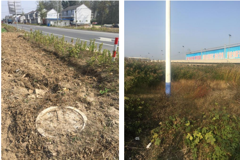
滨海船闸接管口
