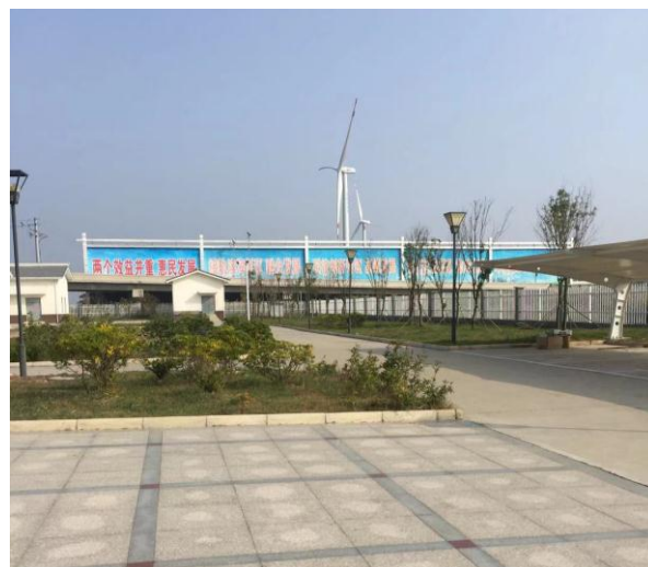
运盐河船闸弃土区现状
