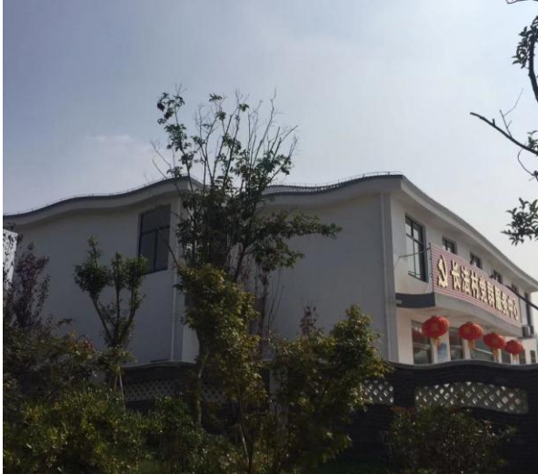
滨海船闸施工期办公区现状
